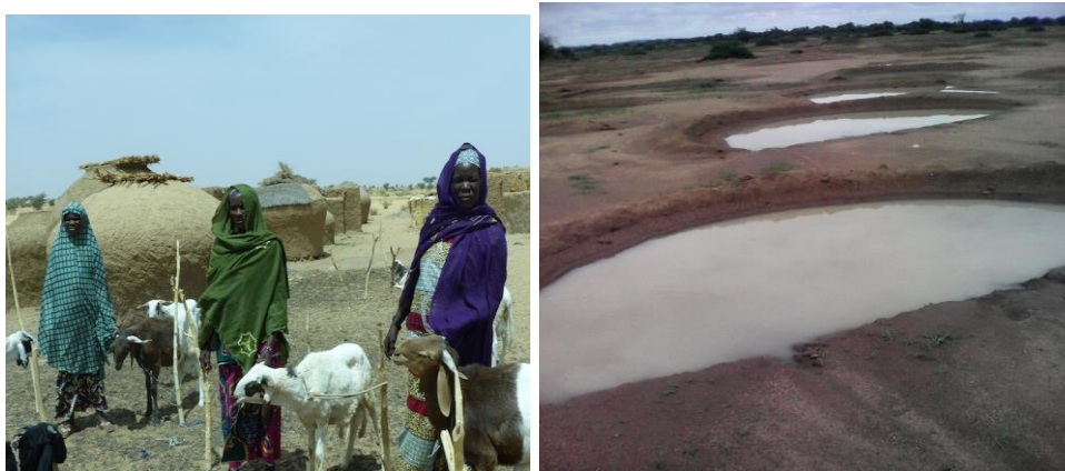
Adaptation face aux Changements Climatiques des populations vulnérables au Niger-Travaux de récupération de terre dégradée en cours
